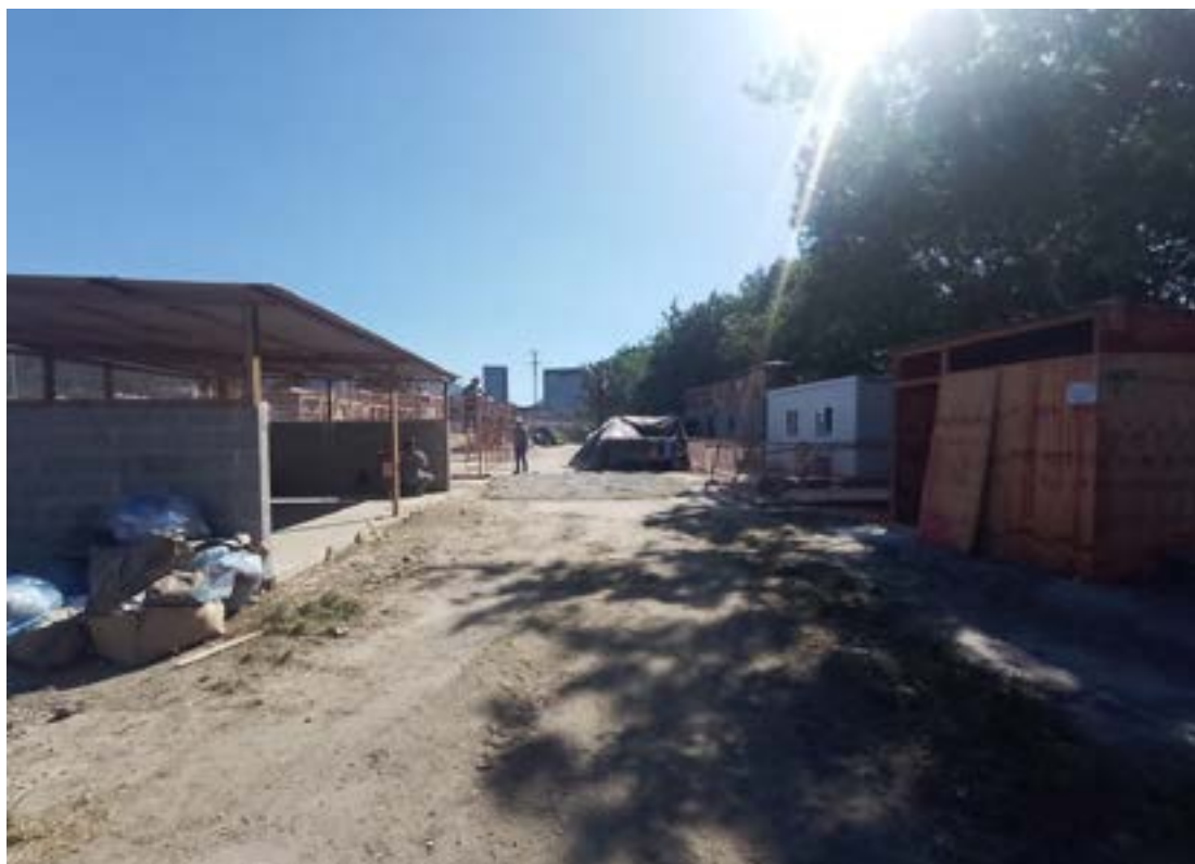
Construção do barracão de obras
