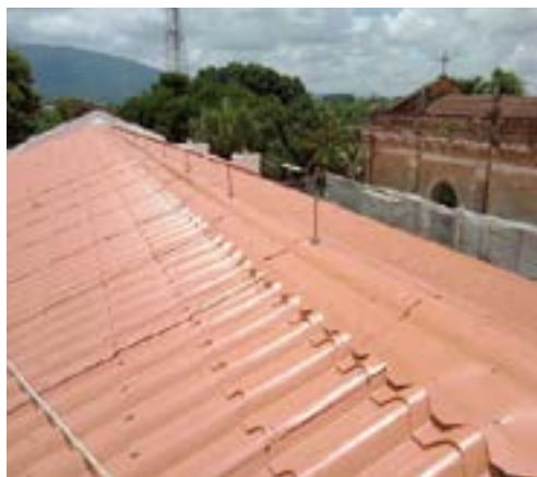
Telhas termoacústicas com instalação de SPDA
