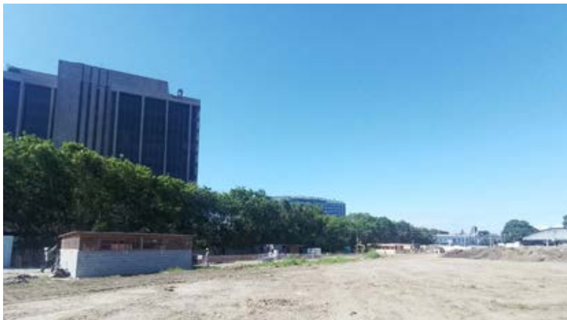
Construção do barracão de obras
