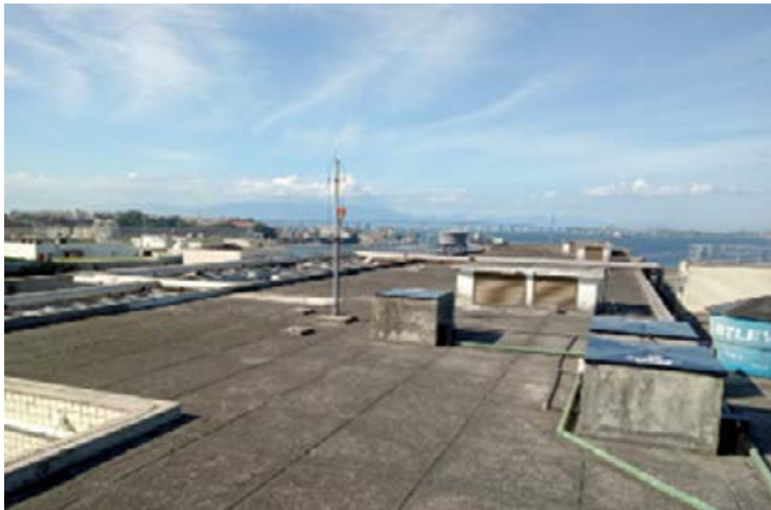
Coberturas – Local onde serão instaladas as placas fotovoltaicas
