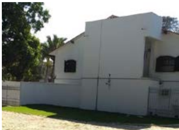
Fachada fundos com castelo d'água finalizado e entrada de carceragem
