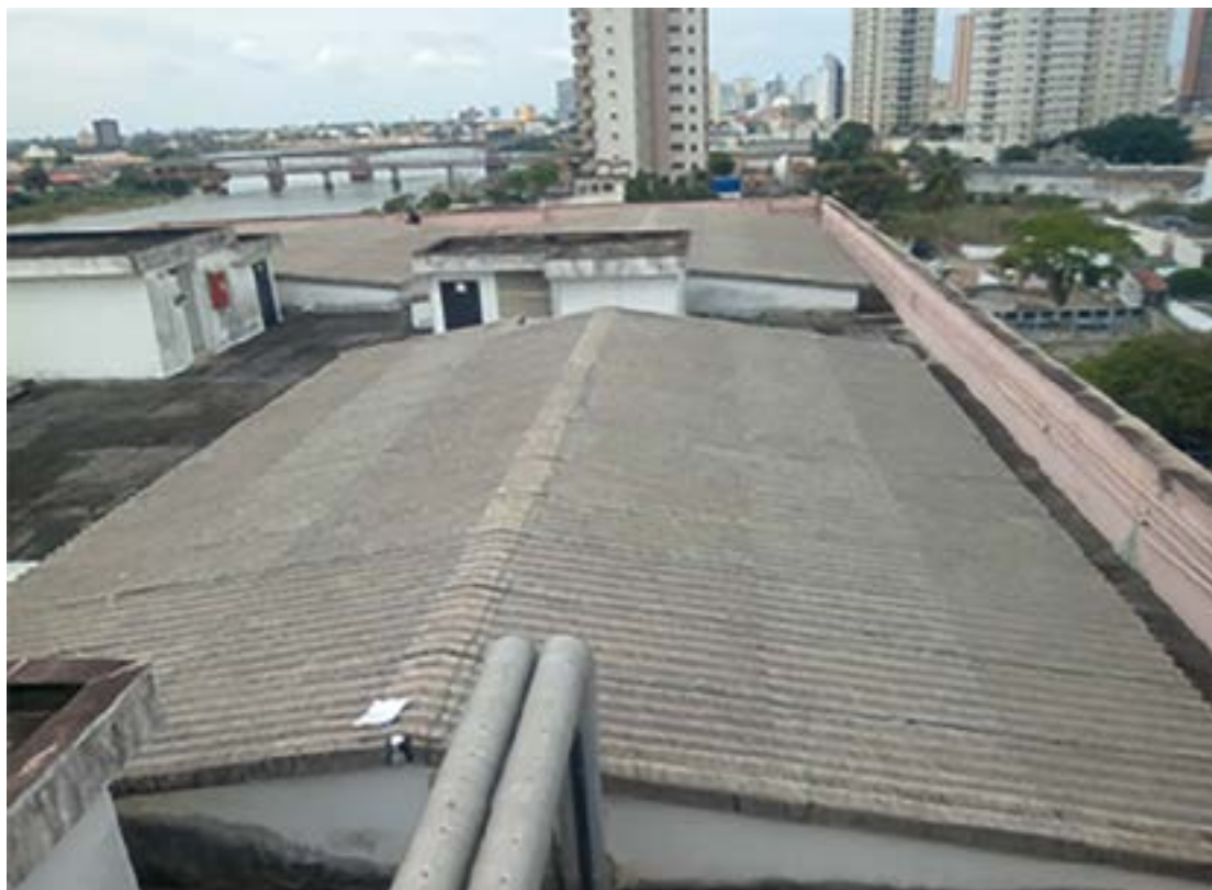
Coberturas - Local onde serão instaladas as placas fotovoltaicas
