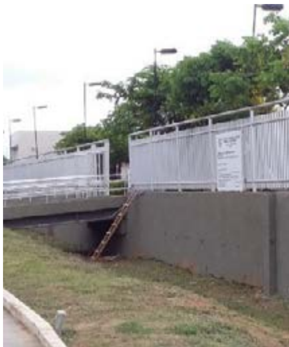
Vista Frontal - Recomposição do muro de concreto armado, emboço e chapisco do trecho que sofreu intervenção e pintura em toda extensão do muro
