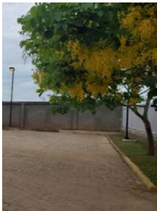
Área Externa - Recomposição de piso intertravado, recolocação do gradil e recomposição do jardim
