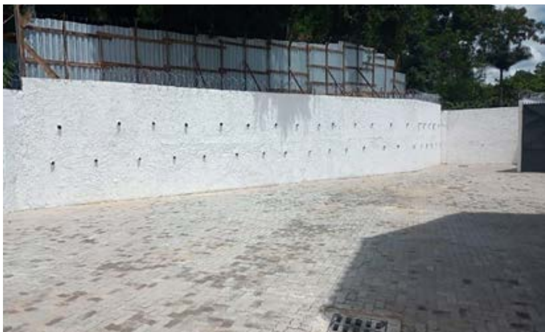
Muro de contenção finalizado
