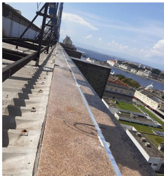
*Visualização do subsistema de captação em barra chata de alumínio instalado para proteção contra descargas*
