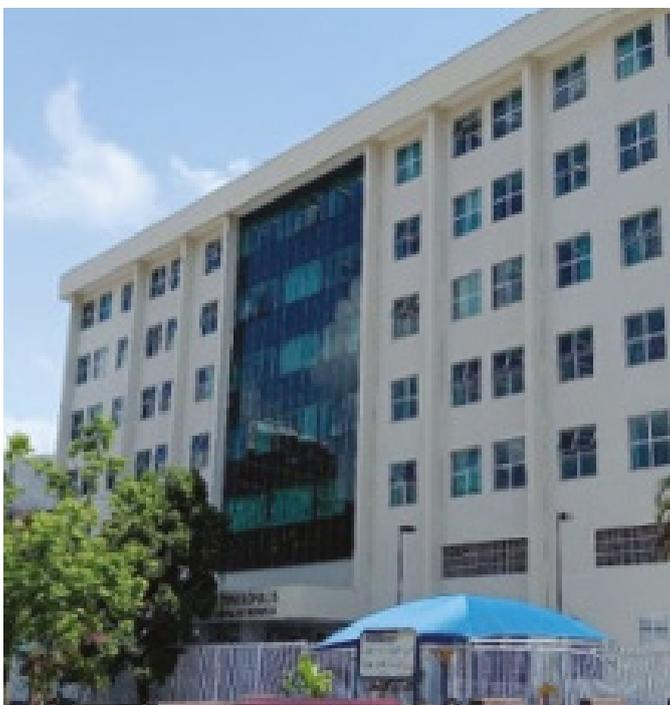
*Fachada principal e lateral após a retirada dos granitos, com pintura e textura*
